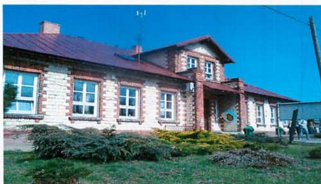
Budynek Urzędu Gminy
